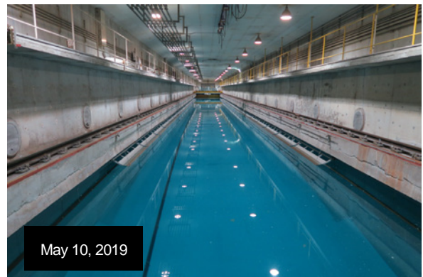
写真2：全面コーティングの後、注水した状態
