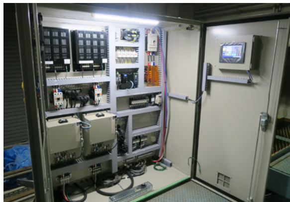
写真4：更新した造波機制御装置
